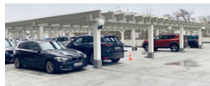
Foto 4. Oberstes Parkdeck östlich HMR 10 bis 14. Foto: Wolfgang Hülle
