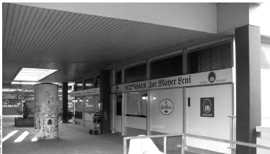
Der Blick vom Kindergarten in die Ladenstraße gleicht einem Tunnel
